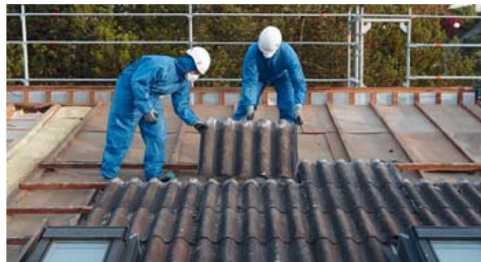
Démantèlement de plaques ondulées
