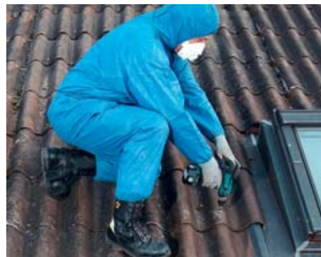
Remplacement de fenêtres de toit
