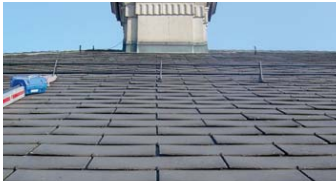
Toit en ardoises
