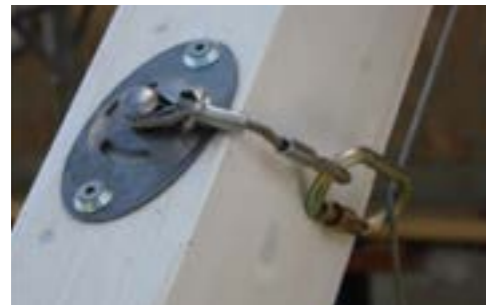
Exemple point B: Glarofix point d'ancrage d'après EN 795
