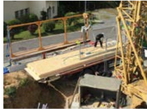
Montage préalable de la protection latérale
