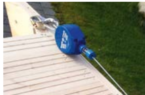
Exemple point A: dispositif d'assurage au faîte
