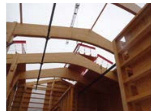
Montage d'éléments de toiture
