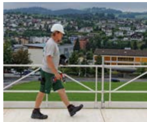
Protection latérale pour le montage préalable (Combisafe)
