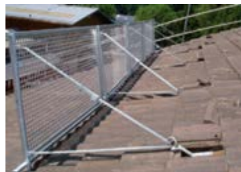
Parois de retenue sur le toit
