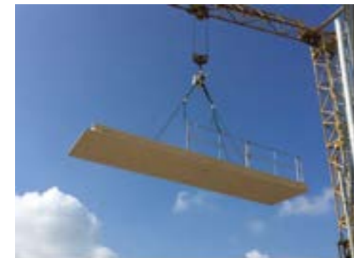
Montage préalable de la protection latérale
