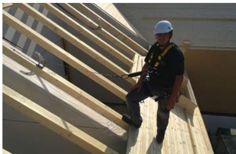
Exemple point B: ABS-Lock DH04 d'après EN795
