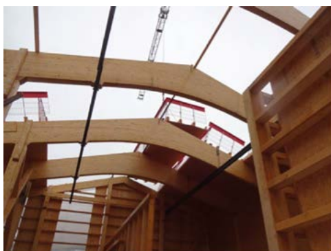
Montage d'éléments de toiture
