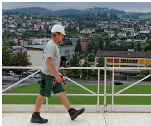
Protection latérale pour le montage préalable (Combisafe)
