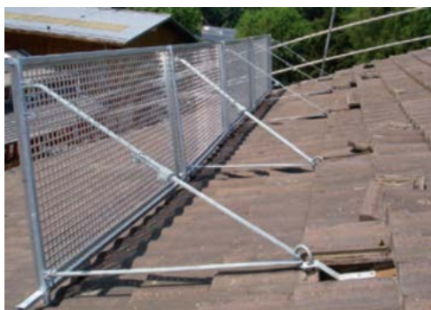
Parois de retenue sur le toit
