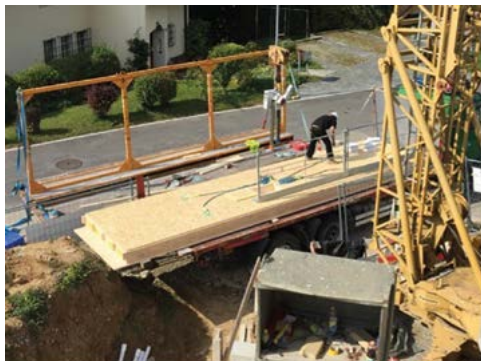
Montage préalable de la protection latérale
