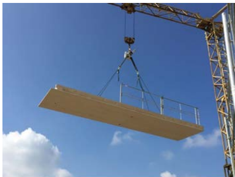
Montage préalable de la protection latérale
