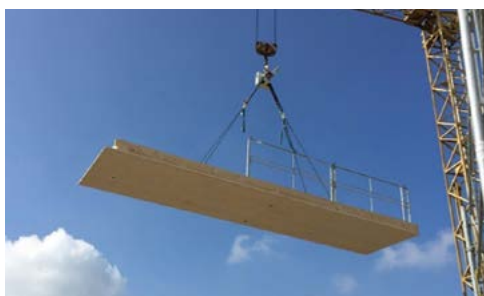
Protection latérale pour le montage préalable (Combisafe)
