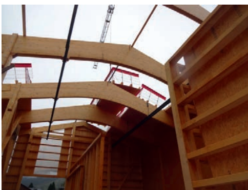
Montage d'éléments de toiture
