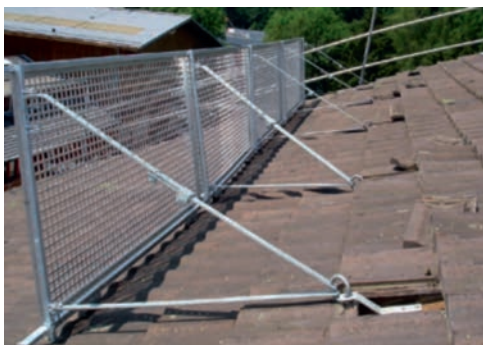
Parois de retenue sur le toit
