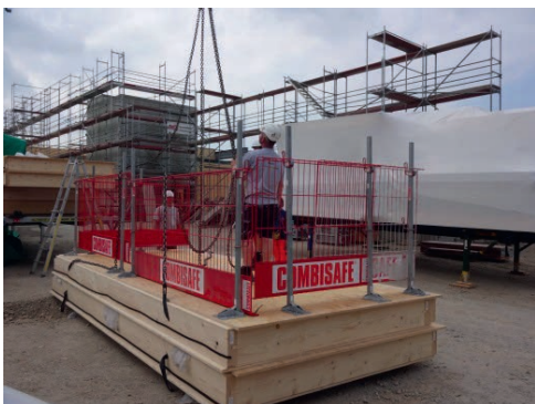
Montage préalable de la protection latérale
