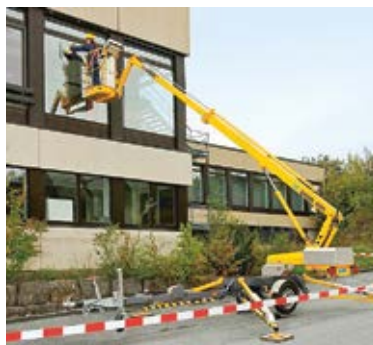
3 Plateformes élévatrices pour les façades difficiles d'accès
