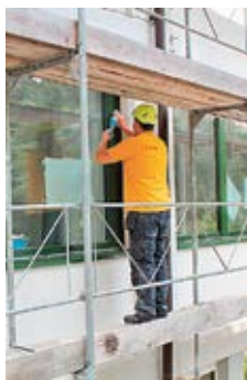
2 Echafaudage de façade utilisé comme protection contre les chutes
