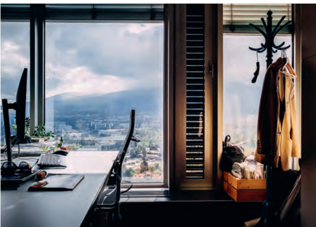
↙ Vitrage antichute d'un immeuble administratif
