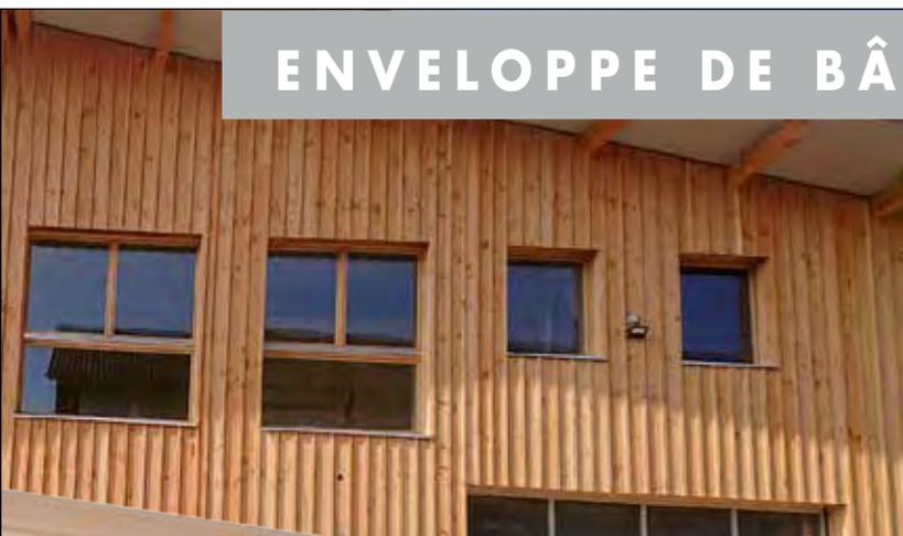
La façade et les fenêtres sont en symbiose parfaite et façonnent l'optique de la halle. **Les fenêtres sont fabriquées à partir de bois en pin suisse, en provenance de la scierie trachsel, bien entendu.**
