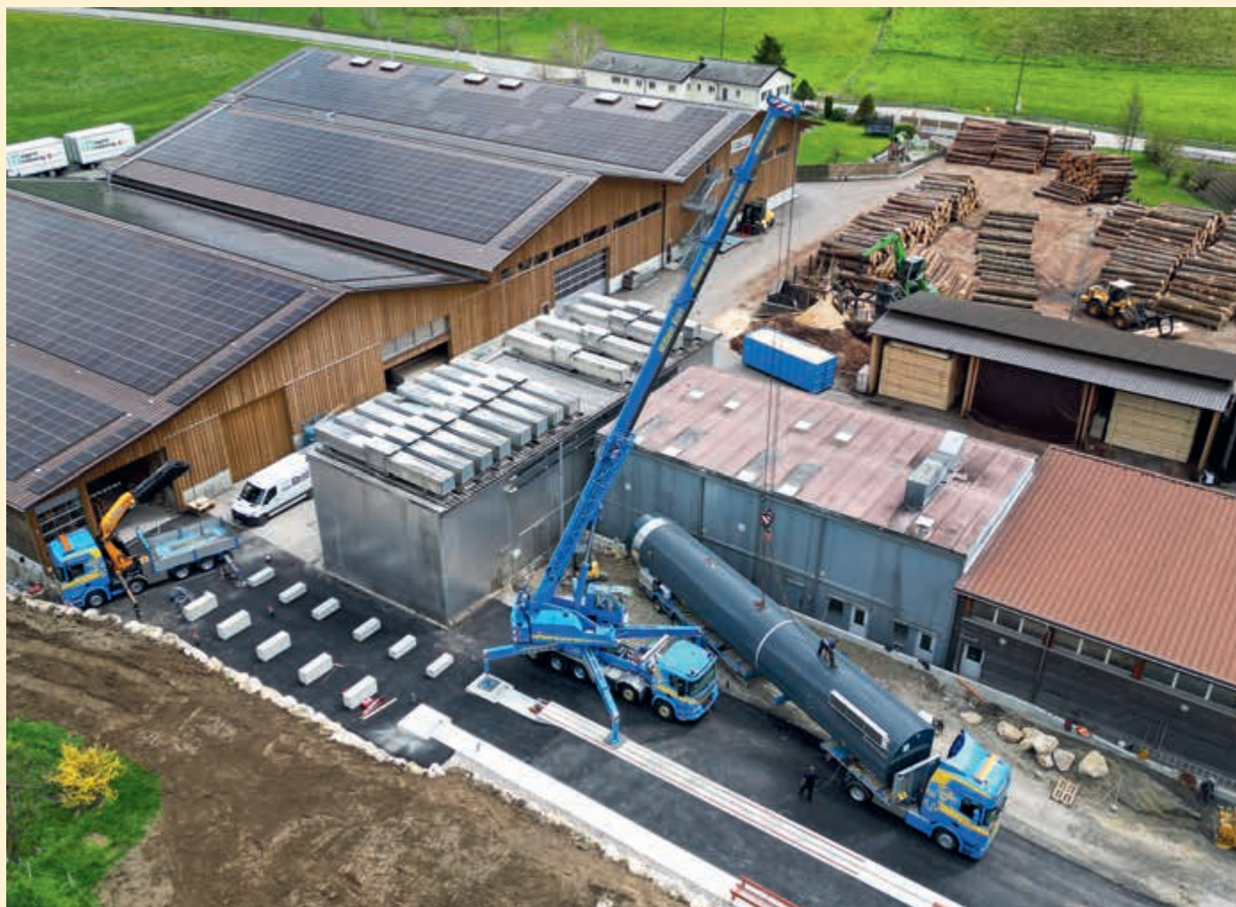
↑ Transport exceptionnel : le séchoir à vapeur en forme de cigare a été livré et positionné via un transport exceptionnel.
