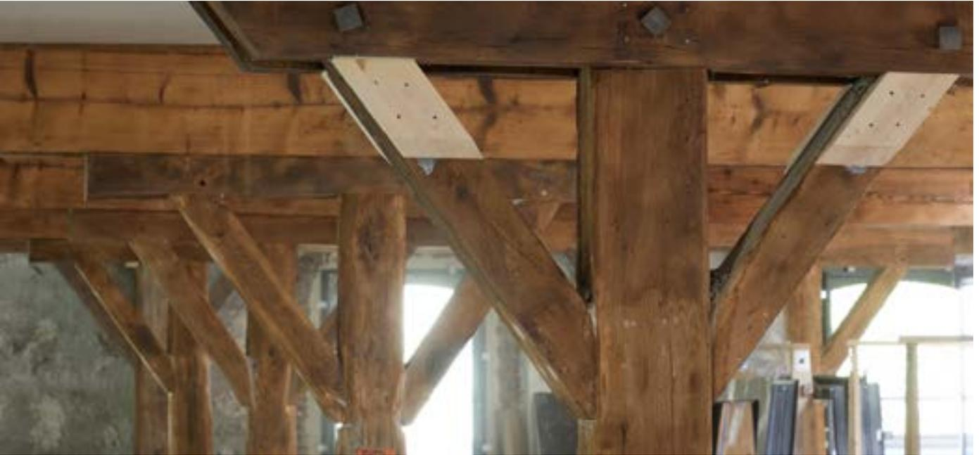
↑ 10 % environ de bois des structures des entrepôts des magasins généraux ont été renforcés. Le reste a pu rester en place, tout en recevant des charges supérieures. (Photo : CBS)
