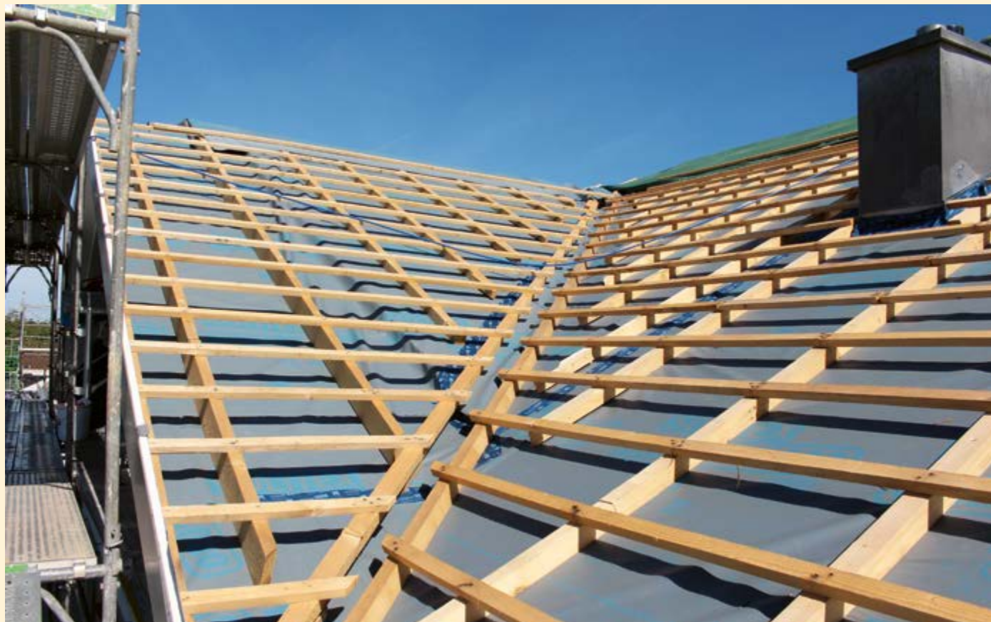
↑ SOLITEX QUANTHO 3000 connect sous contre-lattage.
