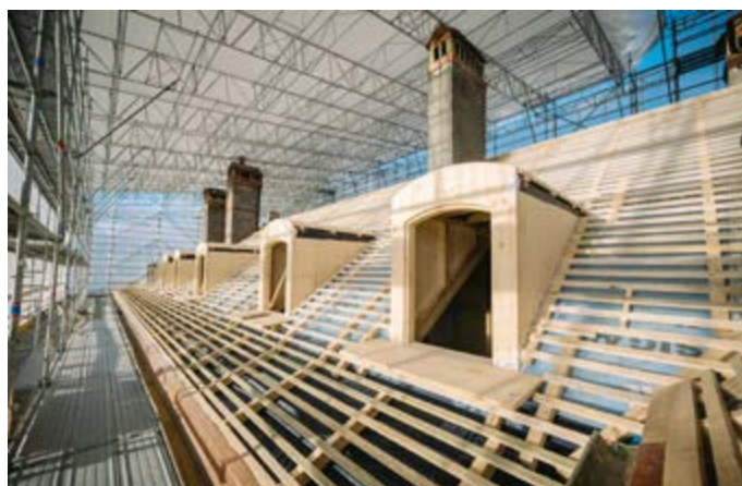
↑ Exemple de rénovation de la charpente du Château d'Hauteville par le Groupe Volet SA. Photo : Groupe Volet SA.
