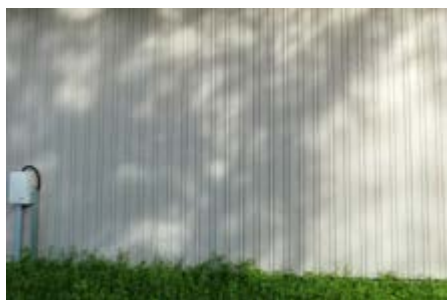
↑ Figure 8: Lames de petites sections vissées – aucune déformation notable dans le temps. Mention cedotec.
