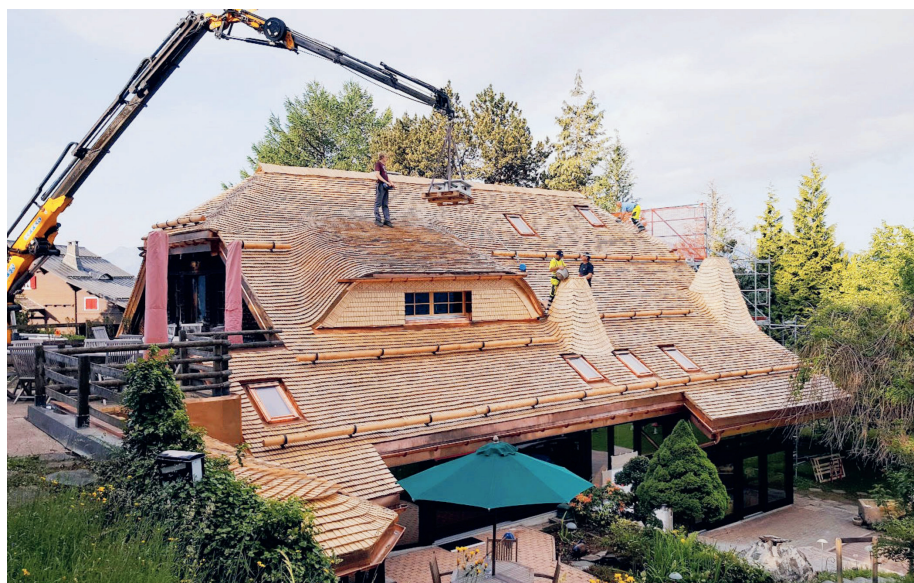
↑ Travail des tavillons, photo : Despond Entreprises Sàrl.
