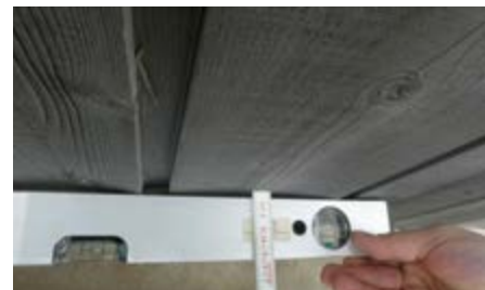
↑ Figure 5: Léger cintrage d'une lame de bardage sans influence sur sa fonction.
