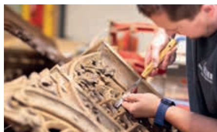
↑ Les parties les plus abîmées ont nécessité un travail de sculpture important ← Si les stalles sont en chêne, les sculptures des évangélistes sont en noyer ↓ Le remontage sur site des stalles s'est effectué étape par étape
