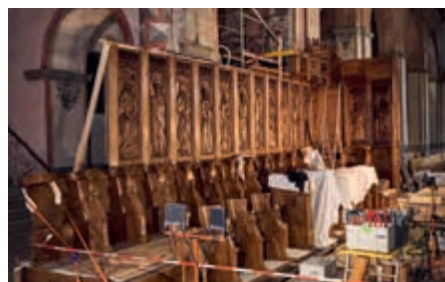
↑ Les parties les plus abîmées ont nécessité un travail de sculpture important ← Si les stalles sont en chêne, les sculptures des évangélistes sont en noyer ↓ Le remontage sur site des stalles s'est effectué étape par étape
