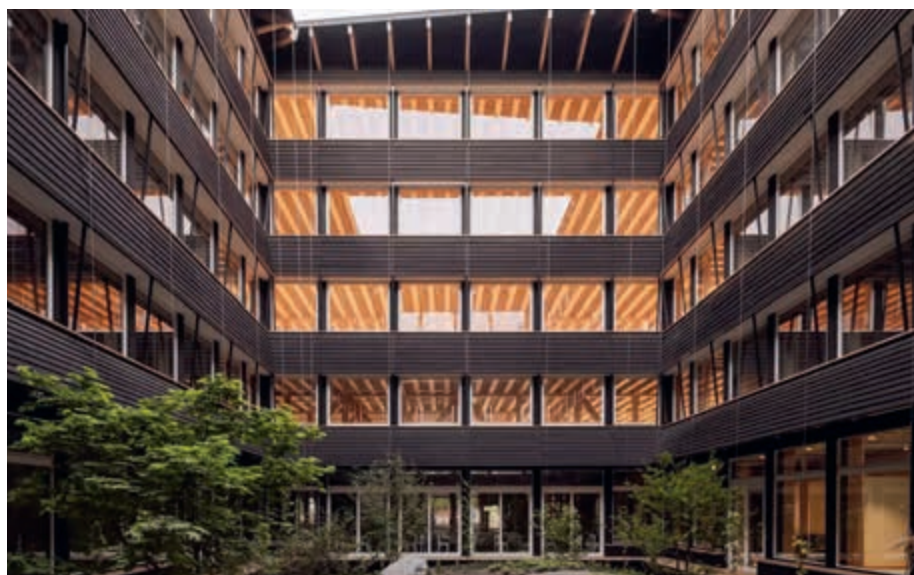
↑ Vue de la cour intérieure du bâtiment Hortus. Photo : Maris Mezulis
