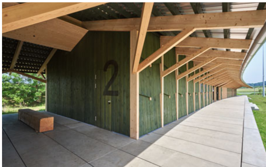
↗ Vestiaire Venoge à Daillens – architecte Localarchitecture – Élément d'ossature bois avec isolation en bottes de paille, 360 mm, recouvert à l'extérieur d'un lé de façade ouvert à la diffusion. Le bois comme la paille sont issus de productions locales, avec un souci particulier de travail de proximité pour toutes les étapes de transformation (séchage, stockage, sciage, assemblage). Ce projet fait figure d'exemple en termes d'utilisation des ressources locales. Photos @cuendet
