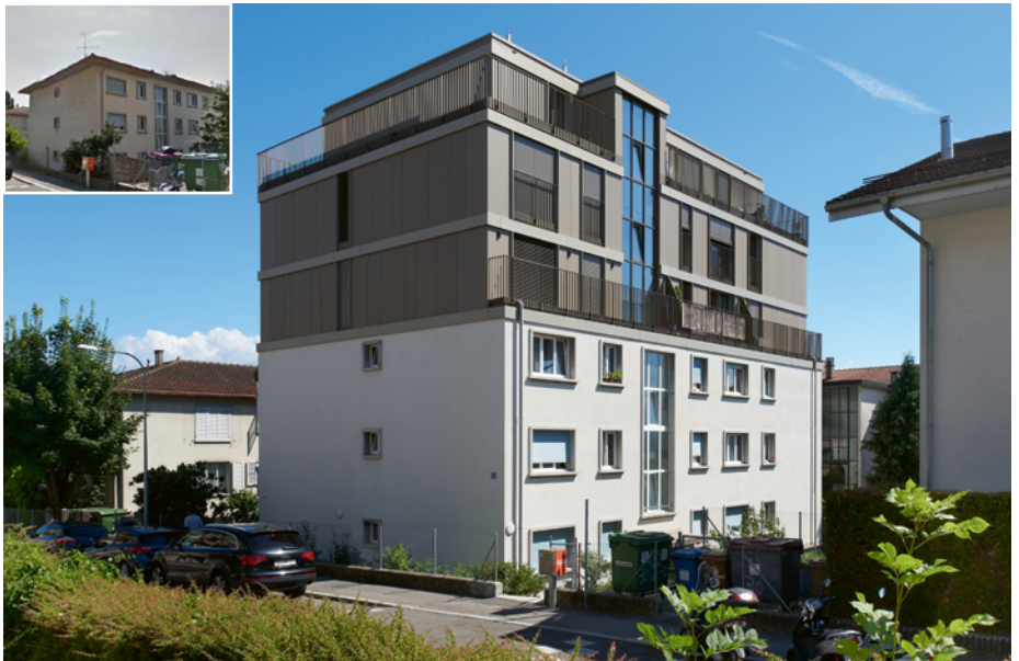
↑ Surélévation de trois étages rendue possible par le faible poids des structures bois avec cage d'escalier et d'ascenseur en bois CLT (REI60-RF). Chemin du Couchant 25, Lausanne, 2019.
