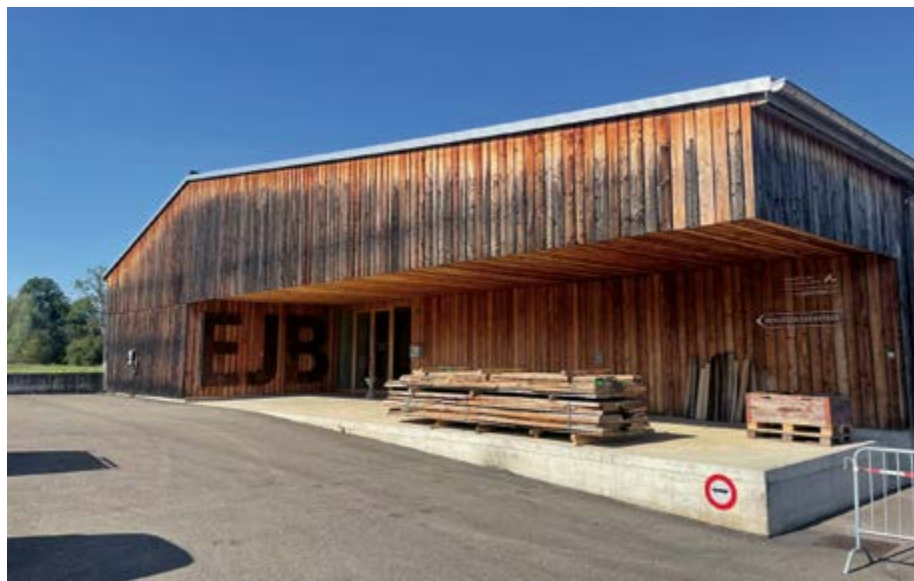
↑ L'EJB avant la mise en œuvre du projet
