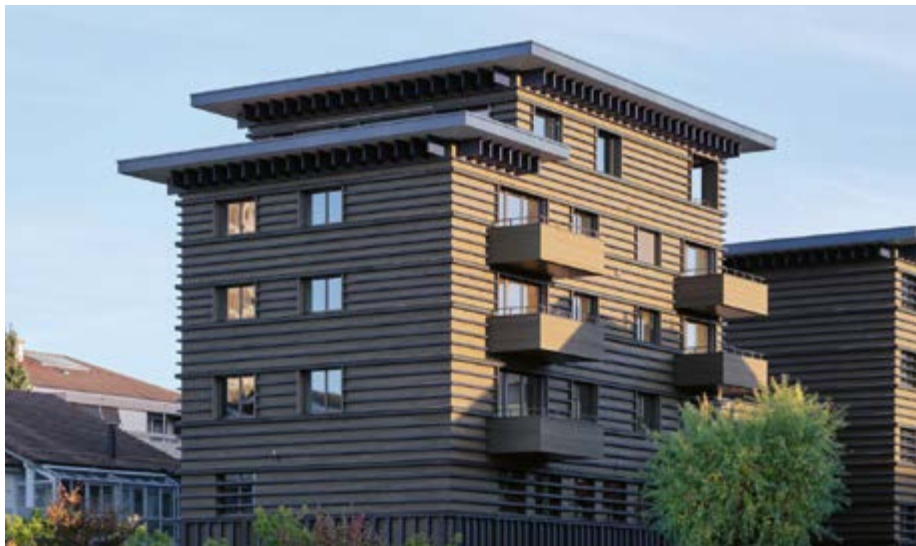
↑ Grâce à la domotique, cette construction bois tournée vers l'avenir est particulièrement efficace sur le plan énergétique
