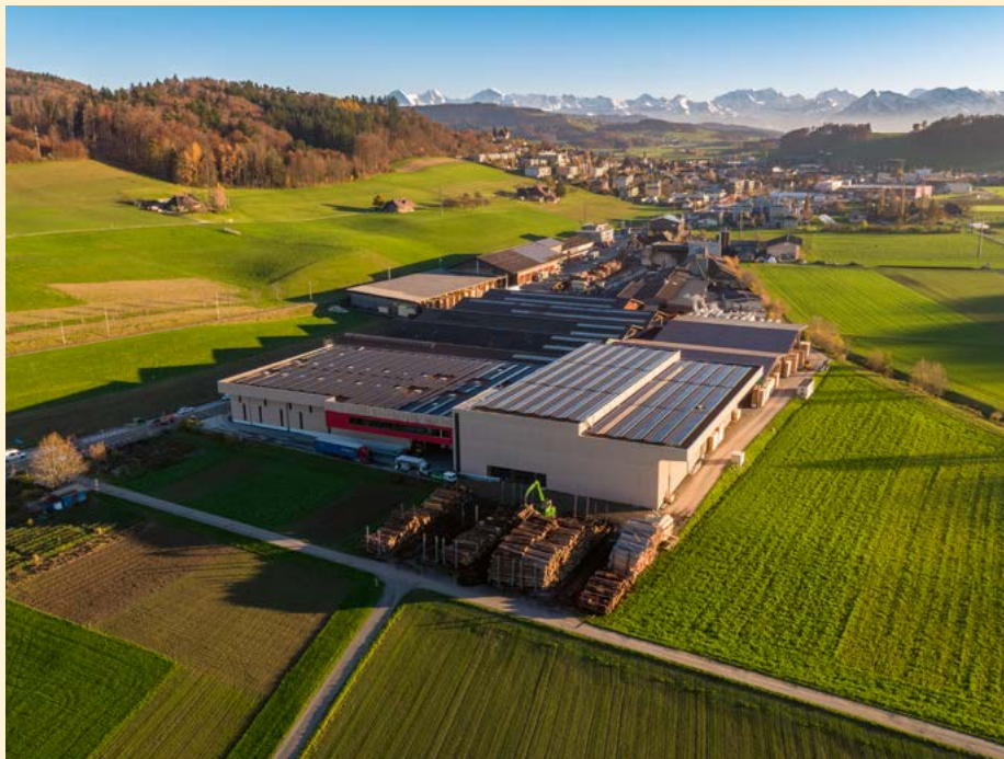
↑ Le nouveau centre logistique avec installations de stockage automatisées et zone de chargement.
