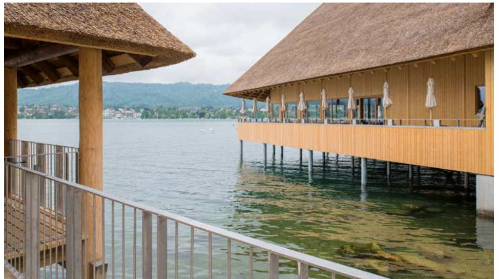
↓ Les différentes constructions sont sur pilotis
