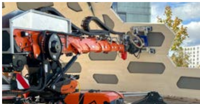
↑ Le montage robotisé du bâtiment
