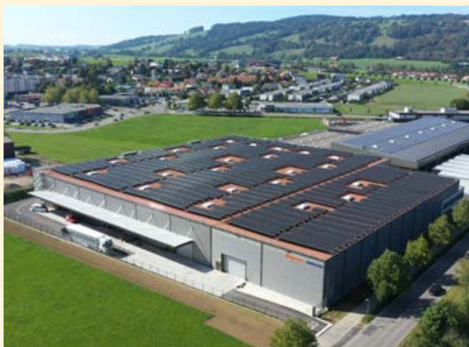
↑ Le nouvel entrepôt de stockage à Bulle
