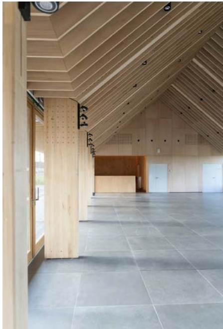
↑ La salle des fêtes de Chemy (59) à structure ossature bois en peuplier. (Photo: L. Duboys Fresney et D. Lermite / face B)
