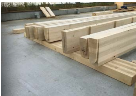
↑ Bois de peuplier collé sur le chantier de la salle des fêtes de Chemy. Photo : L. Dubois Fresney et D. Lermite / face B
