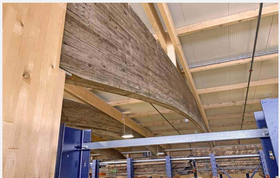
↓ Groupe Corbat - Les grandes arches en bois de l'ancienne patinoire de Porrentruy, d'une portée de 24 mètres, ont trouvé une nouvelle vie en retournant sur les lieux de leur conception à Vendlincourt. Le Groupe Corbat qui avait perdu sa halle suite à un incendie, a pu reconstruire et réutiliser ces éléments qui assument leur demi-siècle d'existence
