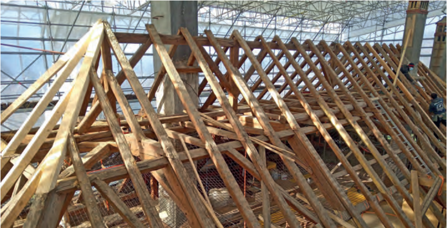
↑ La toiture a été en grande partie conservée. Photo: Philippe Ducaux
