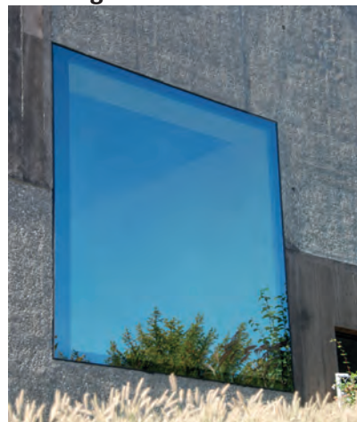
Fenêtre affleurée à la façade également en EI30
