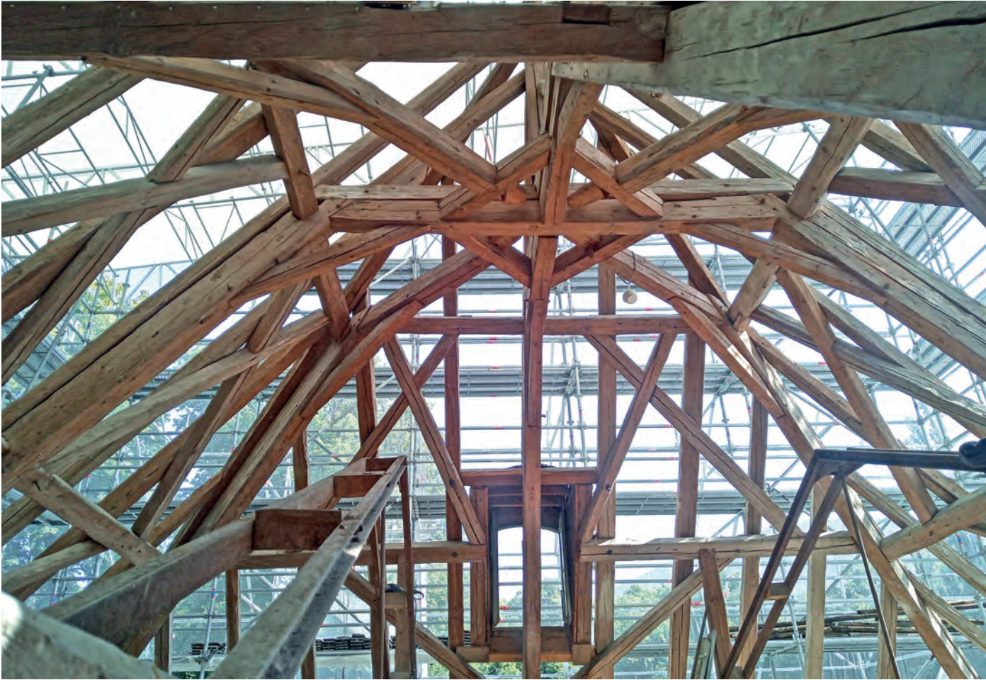
↓ Vue de la charpente en rénovation par l'Atelier Volet SA. Photo: Philippe Ducaux
