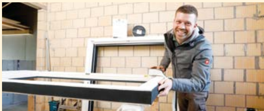
→ Ueli Zihlmann: Lors du montage des fenêtres, Ueli Zihlmann travaille régulièrement avec la bande d'étanchéité multifonctionnelle Permafix 446.
