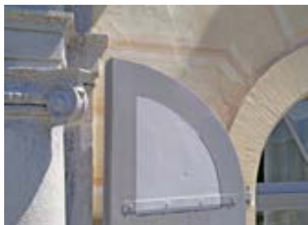
↑ ↗ Rénovation des volets extérieurs. Photos : Philippe Ducraux
