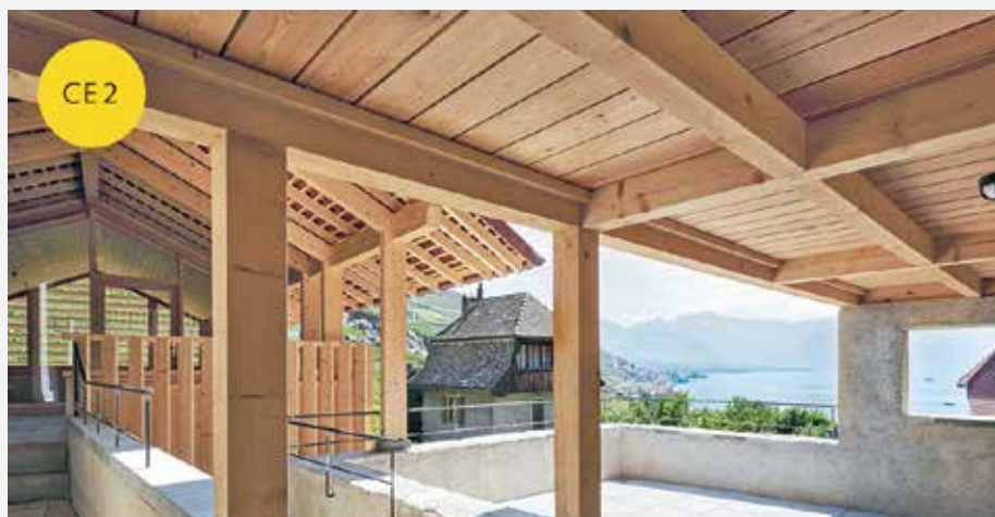
↑ Figure 5: bois protégé contre les intempéries sur les sous-faces, Rivaz, Piuze Ortlieb architectes sa, Corinne Cuendet, Clarens
