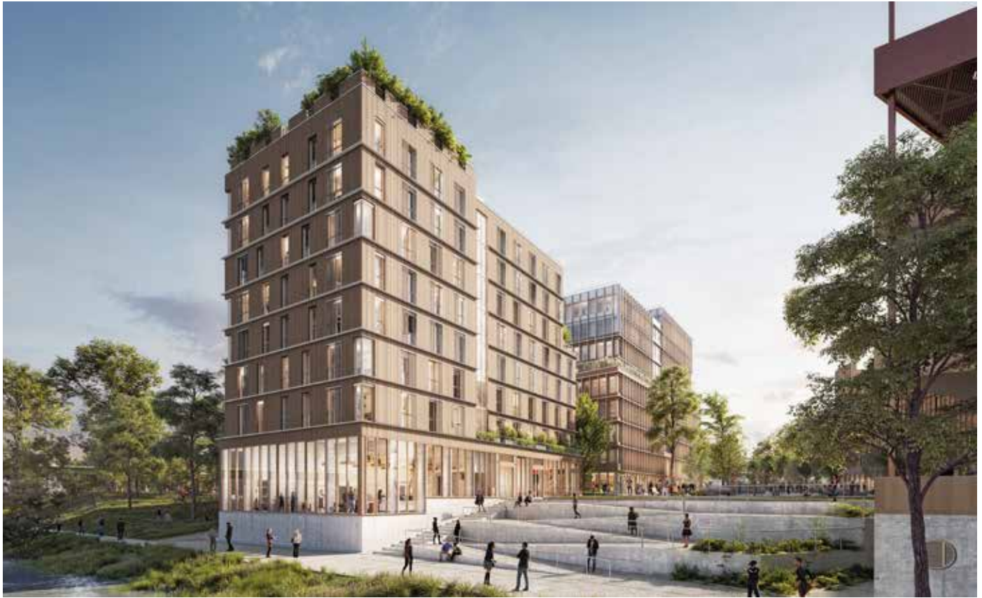
↑ La résidence étudiante de huit étages, d'une surface de plancher de 3 800 m 2 , est composée à 90 % de modules bois préfabriqués en usine. (Crédit : Groupement Pichet-Legendre)
