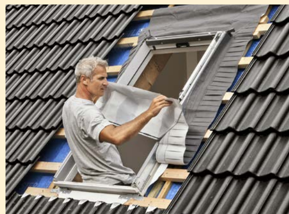
↑ À l'avenir, la bavette de raccordement sera livrée enroulée et devra d'abord être positionnée et fixée en haut de la fenêtre lors du montage. L'installateur pourra ensuite la dérouler petit à petit et la placer dans la position requise.
