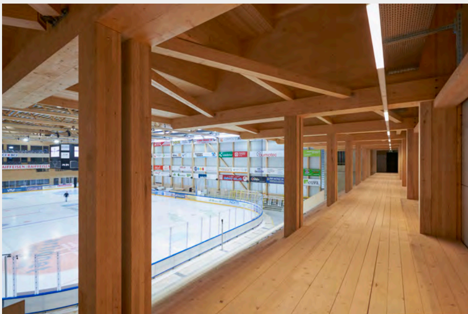
↑ Tasseaux collés en feuillus pour la structure de la patinoire de Porrentruy. Photo : Lignum / Corinne Cuendet, Clarens
