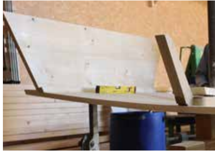
↓ Proue une fois cintrée ↓ Vérification des angles des épontes
