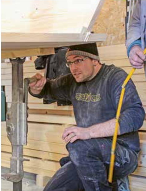
↓ Fixation des épontes sur les traversaux
