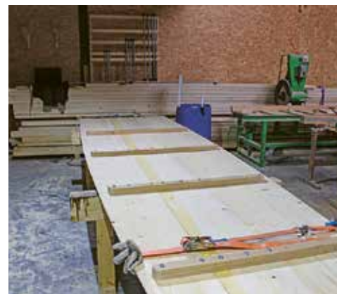
↑ Vissage des traverseaux sur la planche de fond
