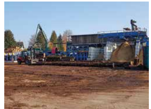
↓ Vue du parc à grumes avec détecteur de métaux et cubage des billons
