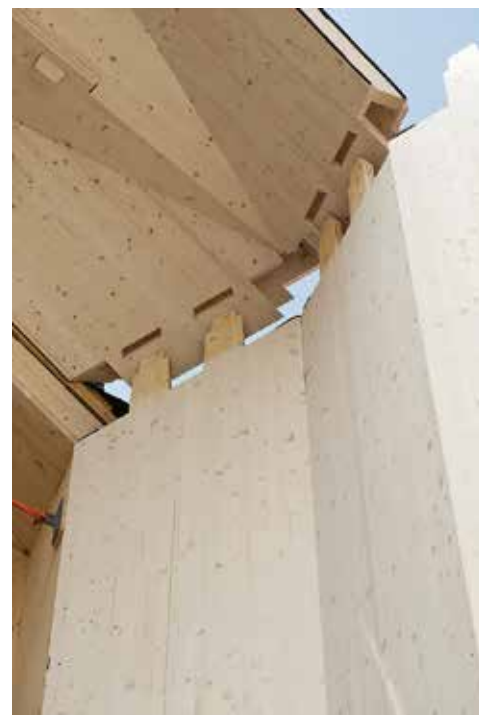
↑ Assemblage de la structure à double couche, chantier, Pavillon de Vidy. Photo: Ilka Kramer
