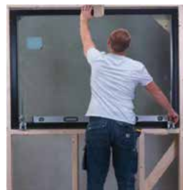
Mise à niveau des fenêtres
