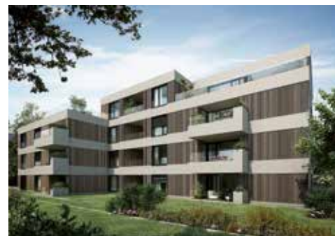
↓ Le VSSM construit un immeuble de 17 appartements locatifs à l'ancien emplacement.
