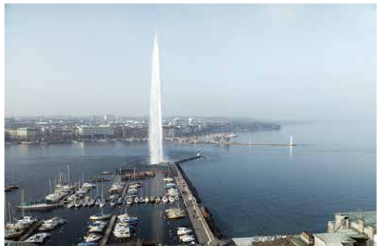
↑→ La Jetée des Eaux-Vives conduisant au jet d'eau avec sa passerelle Photos: HKD Géomatique à Genève pour MID architecture Sàrl
