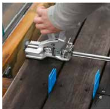
Serrage des lames pour la pose de terrasses bois
