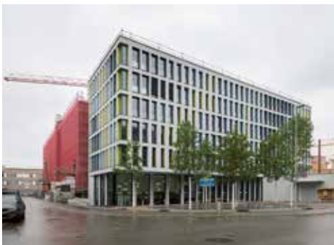
← Nouveau siège à proximité immédiate de la gare de Wallisellen.
