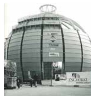
La boule interne recouverte d'éléments nervurés préfabriqués en bois lamellé collé (environ 50 m 3 ) et environ 3000 m 2 de panneaux OSB.
