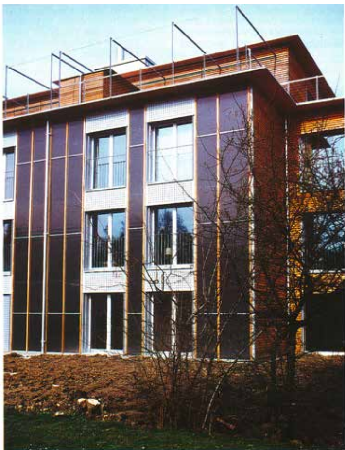
Maison multifamiliale située à la Rychenbergstrasse 294, à Oberwinterthur (ZH): les capteurs en façade (surfaces sombres) produisent de l'air chaud, assurant le chauffage de l'eau. (Photo: Bänninger und Partner, Winterthur).
