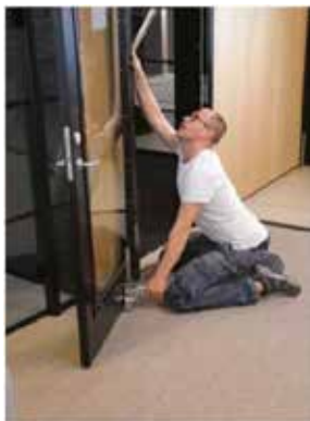
Lever les portes et les dégondrer
