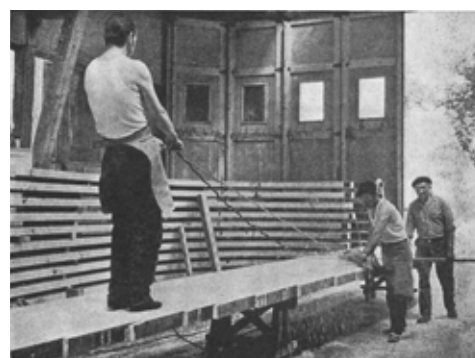
Rabotage. Cette opération peut être réalisée également à l'aide d'une raboteuse de grandes dimensions, mobile autour d'un axe vertical.
