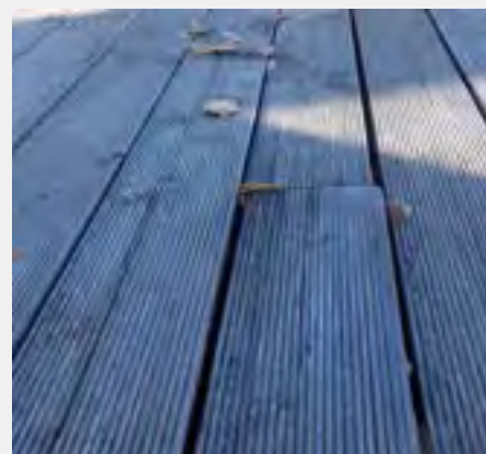
→ Désolidarisation d'une lame à son extrémité - rupture de la rainure avec absence de maintien de la plaque de fixation du clip - avec soulèvement mettant en péril la fonction de marche. Un renfort par vissage visible permet de reprendre cette défaillance ponctuelle. (Photo : ©Cedotec)
