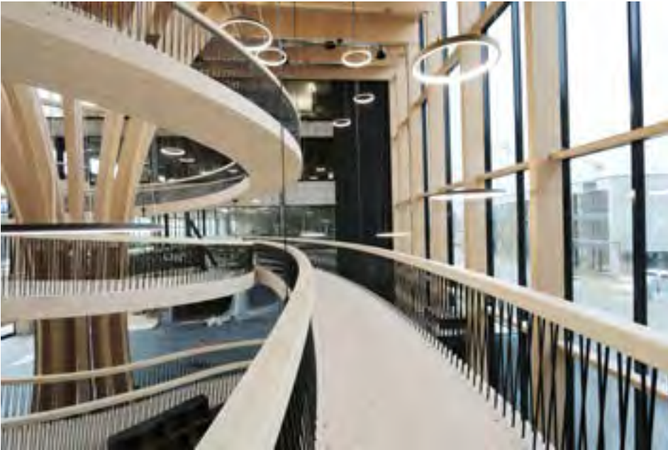
↑ Pose des garde-corps
