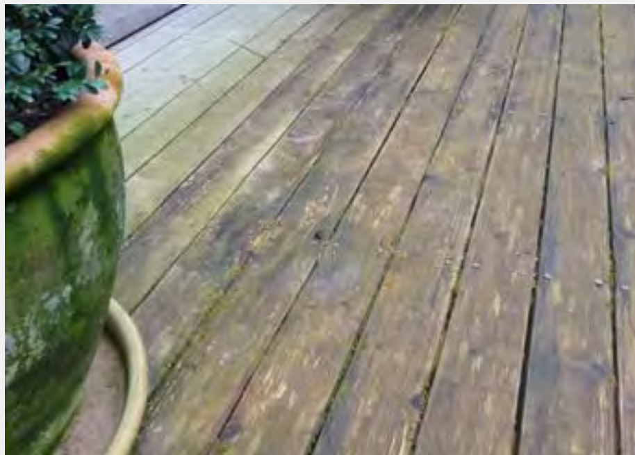
↑ Les impuretés/dépôts verts doivent être éliminés, faute de quoi ils retiennent l'eau et deviennent un terrain favorable pour les champignons, les algues et la mousse. Des trappes d'accès ou la possibilité de démontage doivent idéalement être prévues et documentées de même que toutes les instructions d'entretien (plateforme, écoulement des eaux, nettoyage de la surface). (Photo : ©Cedotec)
