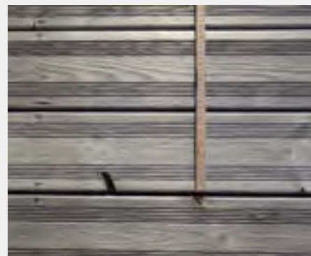
↓ Défauts de surface généralement non admis car pouvant limiter l'utilisation normale d'une terrasse - Eclat important [à gauche] et nœud tombant sur les bords [à droite] - lames en pin sylvestre autoclavé vissées par-dessus et posées en surface d'attique très exposé (Sud-Ouest). (Photos : ©Cedotec)
