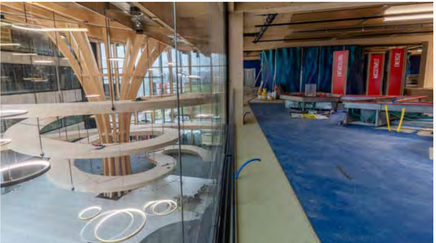
↓ Dans les parties Divertissement/Loisirs, un garde-corps en verre a été ajouté derrière les fenêtres intérieures anti-feu
