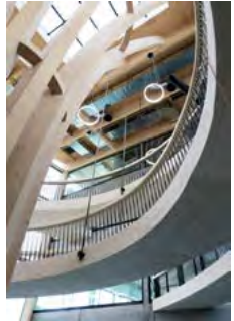
↑ La rampe est suspendue à la toiture, elle-même portée par l'arbre central en lamellé-collé
