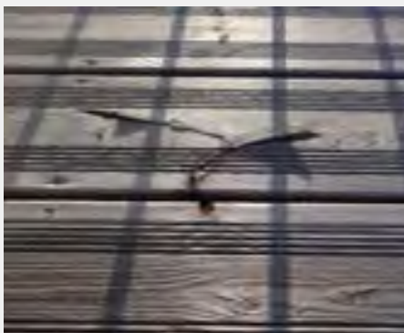
↓ Défauts de surface généralement non admis car pouvant limiter l'utilisation normale d'une terrasse - Eclat important [à gauche] et nœud tombant sur les bords [à droite] - lames en pin sylvestre autoclavé vissées par-dessus et posées en surface d'attique très exposé (Sud-Ouest). (Photos : ©Cedotec)
