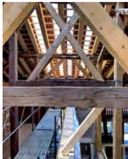
↑ Restauration d'une charpente ancienne dans une ferme en Gruyère
