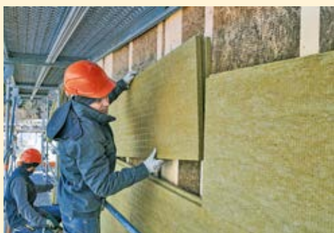
↑ Le montage des panneaux isolants DISSCO est très simple. (Photo : Dominique Uldry)
