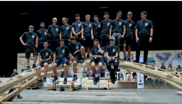
↑ Les charpentiers ont construit un pont de Léonard le dimanche 11 septembre, sur lequel une voiture a pu traverser
