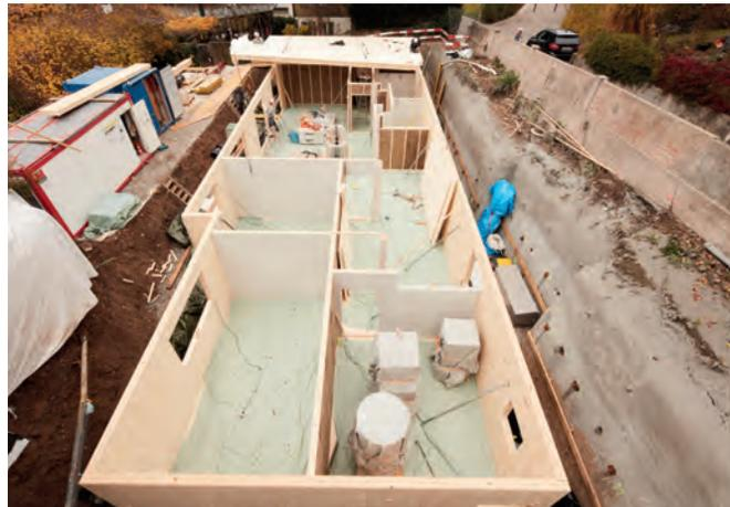
↑ Même la cave est en bois: des panneaux lamellés-croisés sont posés sur une plaque d'isolation de 16 centimètres d'épaisseur; un film EPDM enveloppe le bois pour le protéger de l'humidité.
