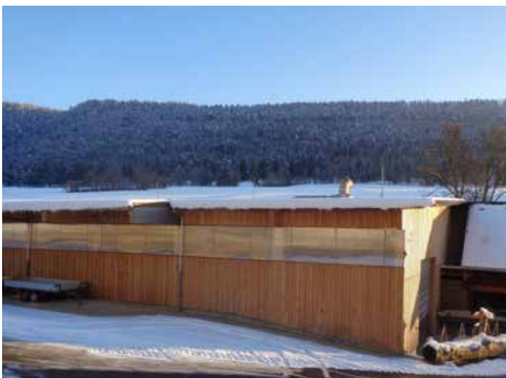
↑ Nouveau hangar de la Scierie SYB Sàrl le jour de son inauguration
