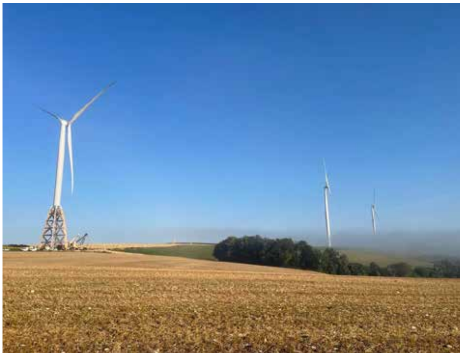
↑ Première éolienne à mât bois-acier mise en production en 2021 en Haute-Marne par la société française InnoVent. (Crédit: InnoVent)
