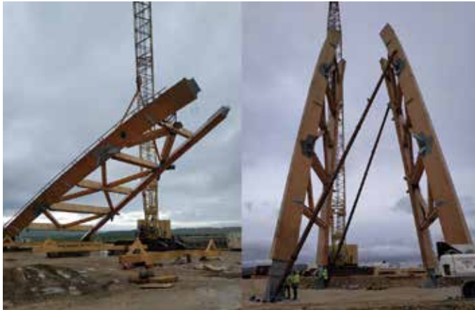
← Pièces du mât de l'éolienne de la société suédoise Modvion. (Crédit: Modvion)
