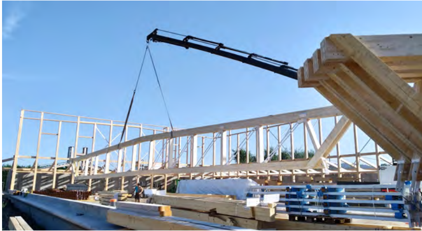
↑ La mise en œuvre des éléments sur le chantier du gymnase de Puy-Guillaume, réalisée par l'entreprise Charpentes Nugues, a nécessité deux convois exceptionnels et cinq camions standard, pour six semaines de levage intensif et une semaine de finition.
