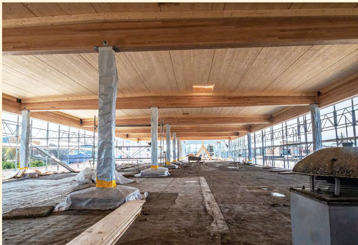
→ Gros œuvre de la surélévation de l'Aligro à Chavannes avec des poutres en bois tasseaux-collés hêtre de Fagus.
