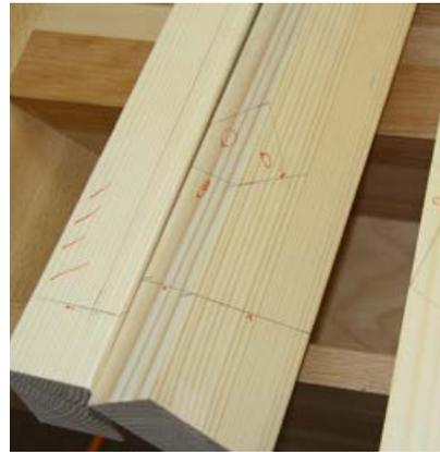
Le traçage du bois est un élément essentiel, il est l'intermédiaire entre le dessin et la taille. Il va de soi qu'il est essentiel de garder une grande précision. Il joue aussi un rôle important sur l'aspect général de la maquette.
