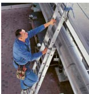
1 Échelle sécurisée contre tout risque de glissement
