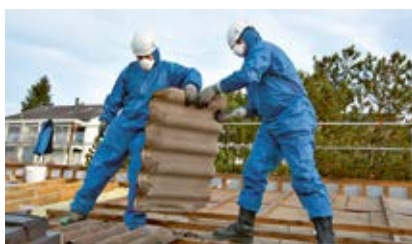
1 Lors des travaux de démontage, les plaques de fibrociment contenant de l'amiante doivent être laissées en l'état.
