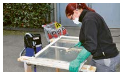
2 Mesures de protection lors du retrait du mastic de vitrier contenant de l'amiante
