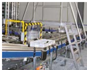
3 Passerelle au-dessus d'un transporteur à rouleaux
