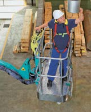
Règle 1 Prévenir les chutes.
