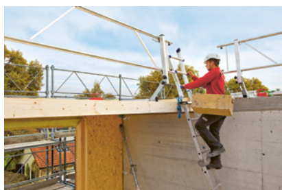
1 La bonne échelle au bon endroit: pour pouvoir accéder en toute sécurité à chaque poste de travail.
