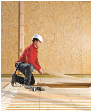
Règle 2 Sécuriser les ouvertures dans les sols.
