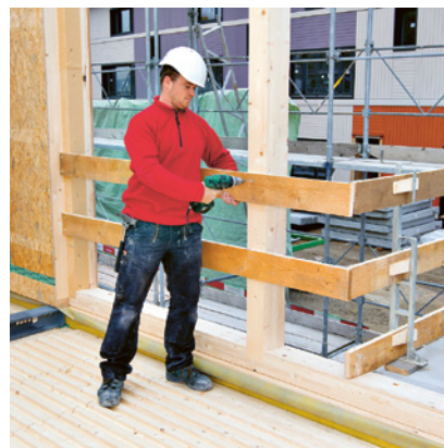
3 Ouverture dans une paroi sécurisée par un garde-corps
