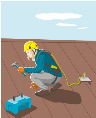
Règle 8 Utiliser correctement les EPI contre les chutes.
