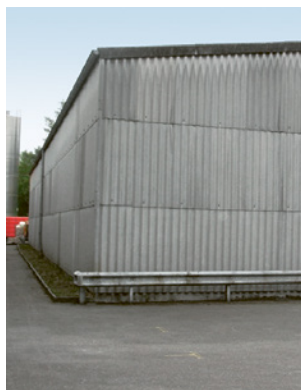
1 Revêtement de façade composé de plaques amiantées.
