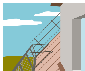
4 Paroi de retenue et protection du pignon sur toit existant.
