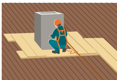
2 Poste de travail rendu praticable avec des plateaux, EPI contre les chutes (voir règle 8.)
