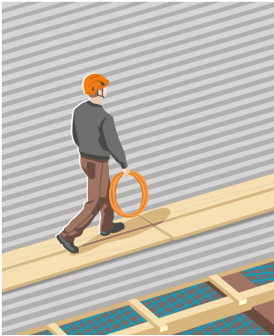
Règle 5 Vérifier la résistance de la couverture.
