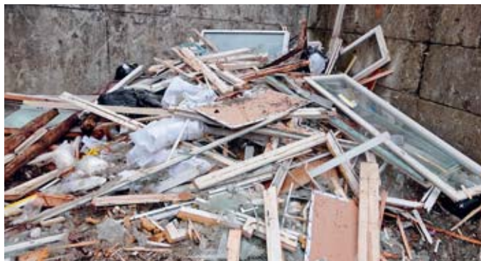
Cadres de fenêtres en bois d'une ancienne construction
