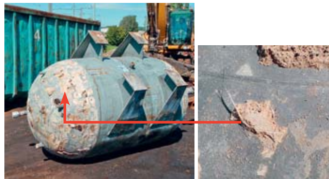
Isolation amiantée d'un réservoir d'eau
