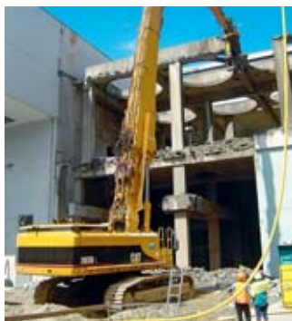
Démolition de bâtiment
