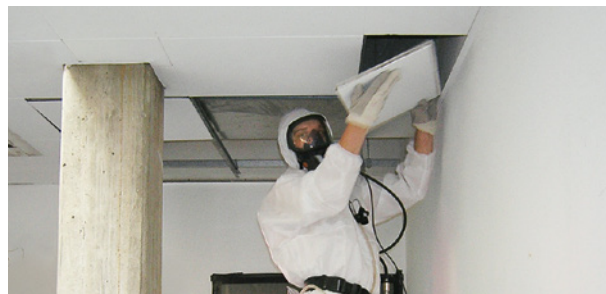
Enlèvement par une entreprise en désamiantage reconnue
