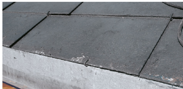
Ardoises de toitures
