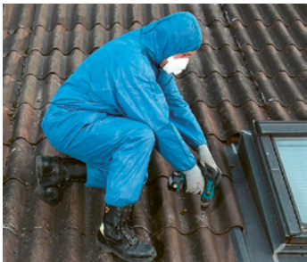
Remplacement de fenêtres de toit
