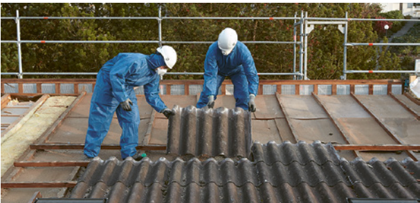
Démantèlement de plaques ondulées
