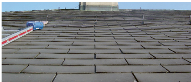
Toit en ardoises
