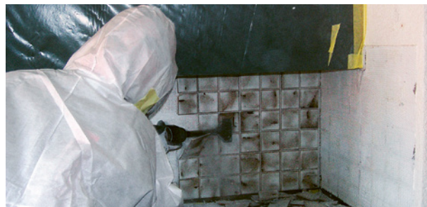
Enlèvement par une entreprise de désamiantage reconnue
