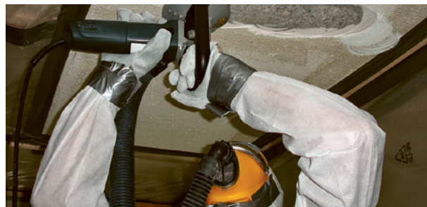
Enlèvement par une entreprise de désamiantage reconnue
