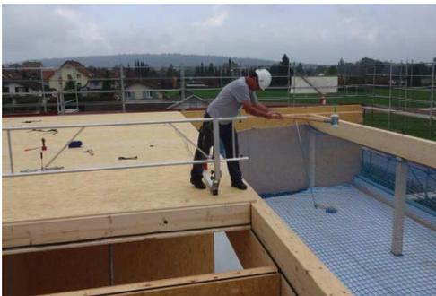
Les systèmes de protection latérale temporaires se prêtent pour des constructions simples afin de sécuriser la bordure de montage.
