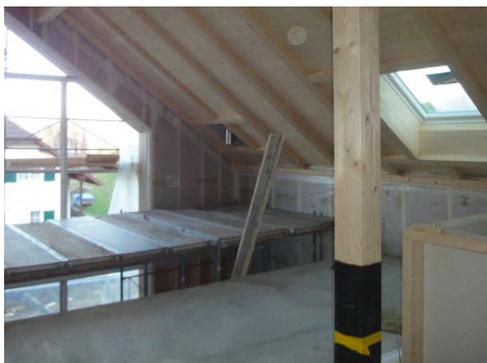
L'échafaudage de retenue peut également être employé pour un montage sûr de l'isolation de toiture et de la couche d'étanchéité à l'air.
