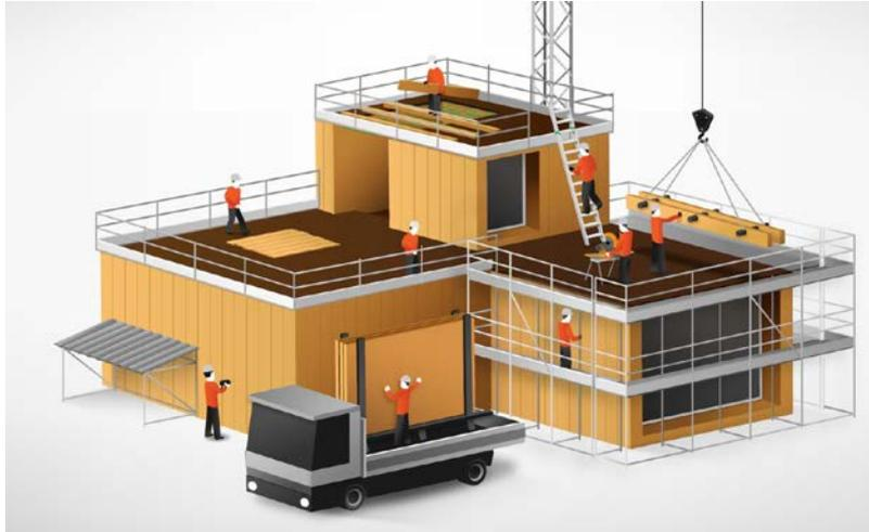
La loi suisse met la priorité sur les mesures de protection collectives, telles que les protections latérales, les échafaudages, les filets sécurités ou les échafaudages de retenue, de manière concrète et consacre, avec l'art. 36 de l'Ordonnance sur les travaux de construction (OTConst), l'obligation du montage d'un filet sécurité ou d'un échafaudage de retenue lors de la couverture de toits.
