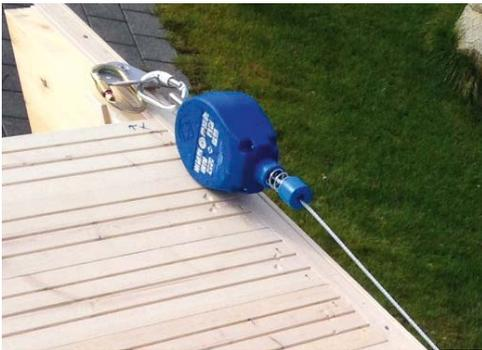
Exemple point A: dispositif d'assurage au faîte
