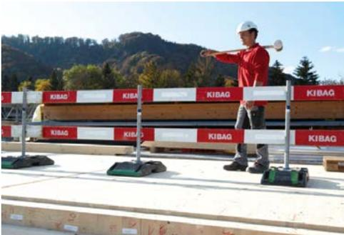
Des socles en caoutchouc peuvent être utilisés comme délimitation et doivent être montés à au moins 2 m du bord de la zone présentant un risque de chute.
