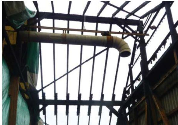
En raison d'un danger d'effondrement imminent, l'accès à la construction du toit n'est pas autorisé.
