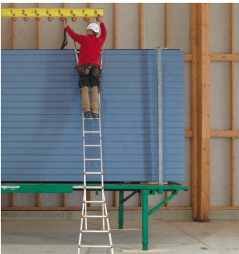
Le travail avec les outils appropriés ou les mesures de protection contre les chutes est plus simple à réaliser lors du chargement dans l'atelier que lors du déchargement au chantier. Toutefois, tous les processus doivent être observés lors de la production, du chargement, du déchargement et du montage.
