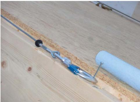
Exemple point C: fixation du mousqueton de sécurité
