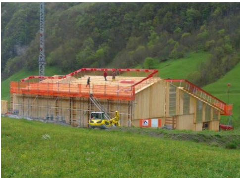
La protection contre la chute vers l'extérieur doit être assurée par un échafaudage de façade avec un pont de ferblantier / une paroi de protection de couvreur et une protection latérale le long du pignon.
