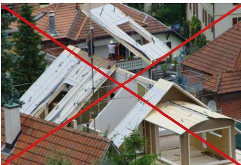
La protection contre la chute vers l'extérieur doit être assurée par un échafaudage de façade avec un pont de ferblantier / une paroi de protection de couvreur et une protection latérale le long du pignon.
