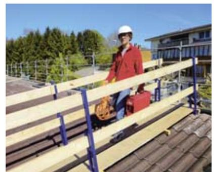
**3** Surfaces de toiture non résistantes à la rupture: utiliser des passerelles.
