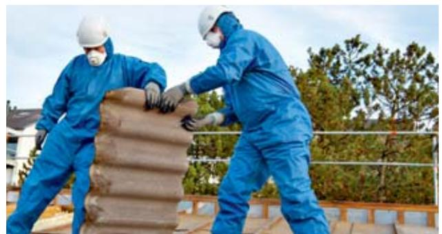
**2** Interdiction de casser, scier, percer ou meuler des plaques de fibrociment lors des travaux de déconstruction.
